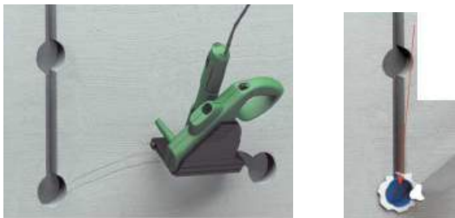
6.28-сурет - Тескішпен тесіктерді тесу және қораптарды орнату
