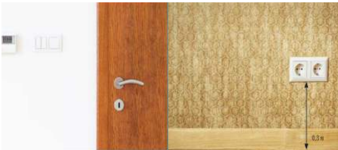
6.26-сурет - Ажыратқыштар мен розеткаларды монтаждау
