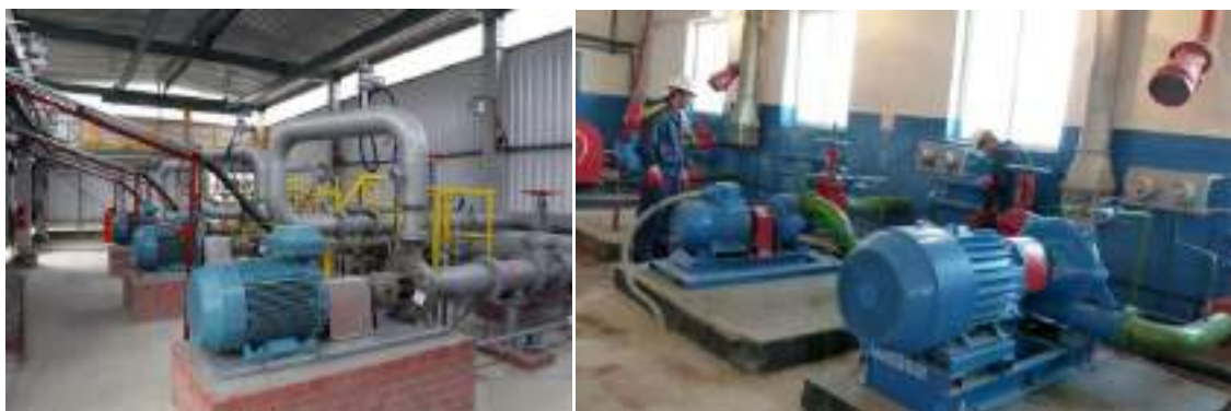
Сурет 5.26- Мұнай қоймасындағы сораптық станциялар
