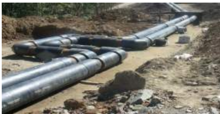
Сурет 5.2-II тәрізді компенсатор
