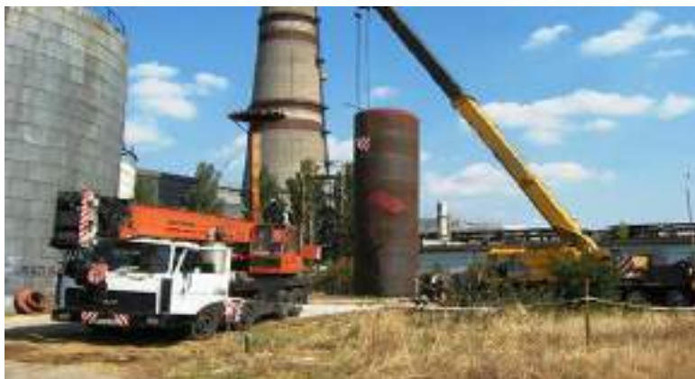
Сурет 9.21-Резервуардың түбін жөндеу
