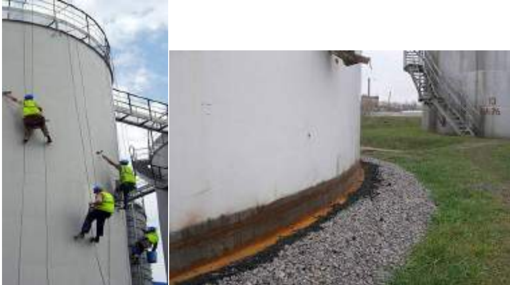
Сурет 9.19- Резервуарларды ағымды және күрделі жөндеу
