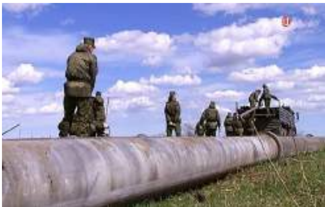
Сурет 4.8- Құбыр жолдарын пісіріп-дәнекерлеп жалғау
