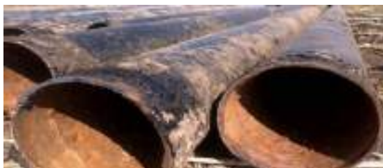
Сурет 2.11- Құбырлар коррозиясы
