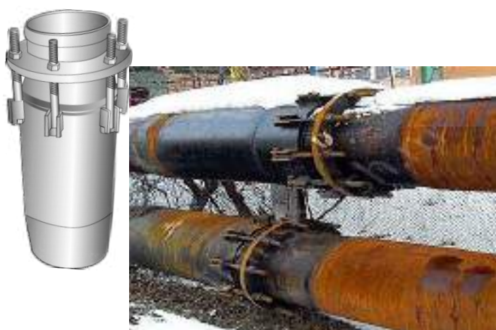
Сурет 5.4- Сальникті компенсаторлар
