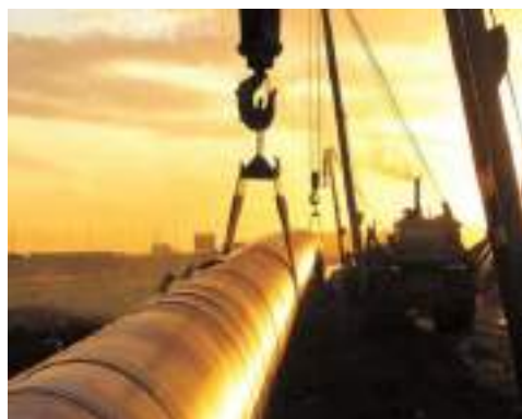
Сурет 4.7- Құбыр жолдарын траншеяға төсеу
