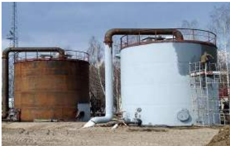
Сурет 9.18-Резервуарларды жөндеу
