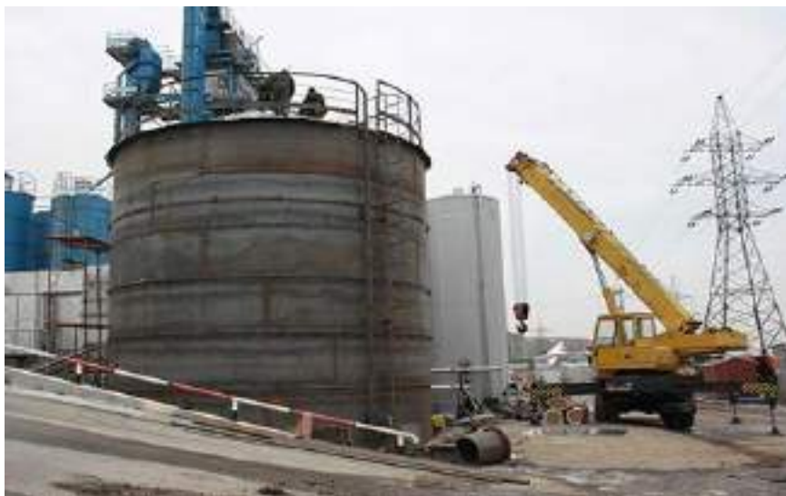
Сурет 9.20-Темір бетонды резервуарды жөндеу жұмыстарына дайындау
