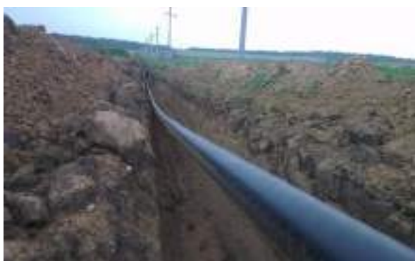
Сурет 4.7- Құбыр жолдарын траншеяға төсеу
