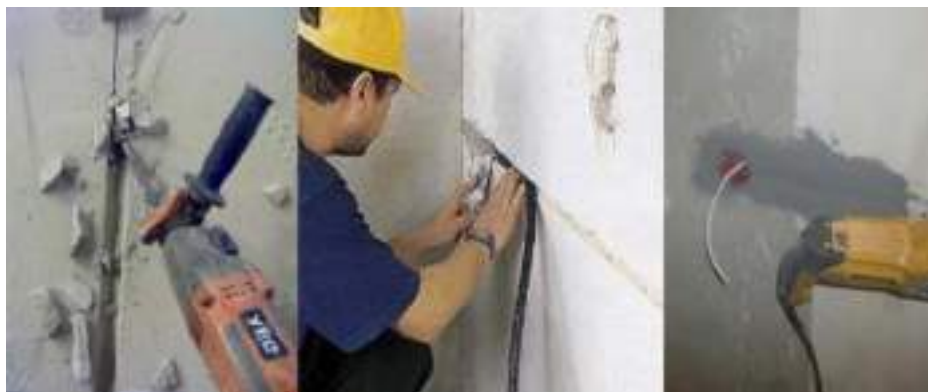
2.2.5.2 -сурет. Кабель сымдарын төсеу әдістерінің бірі.
