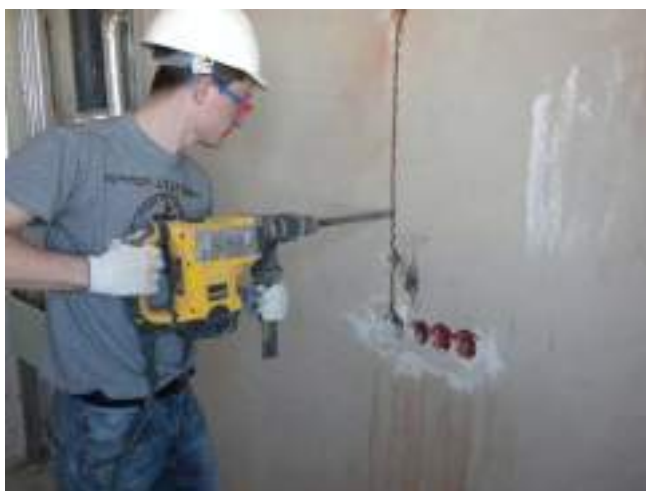
2.2.5.4-сурет Сымдарды төсеуге арналған электр құралын пайдалану.
