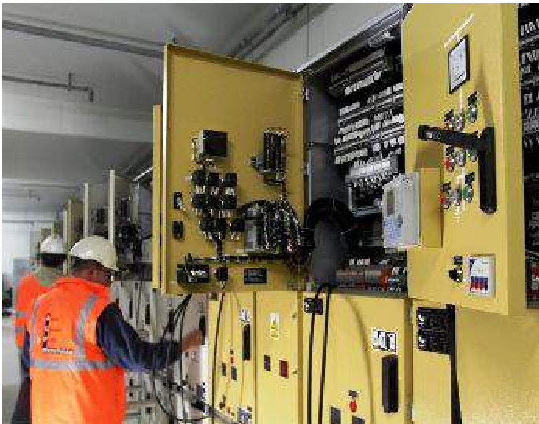
5.3.1.2-сурет. Жоғары вольтты ұяшықтардың релелік қорғанысын баптау
