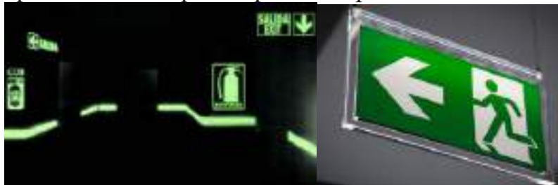
2.2.1.3-сурет. Эвакуациялық жарықтандыру
