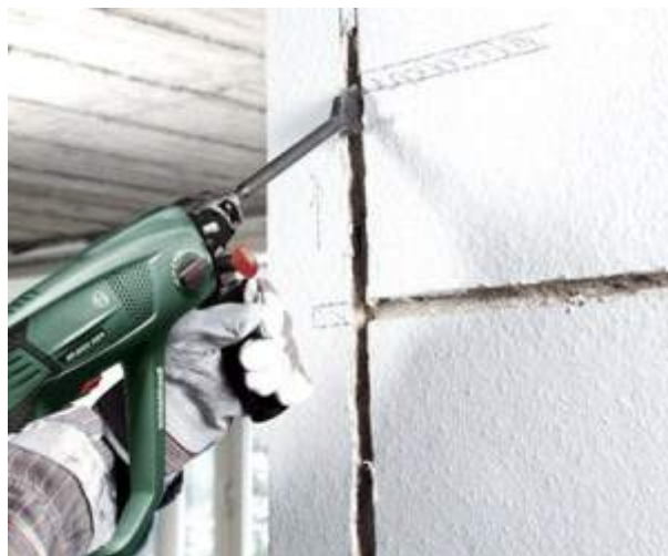
2.2.4.4-сурет. Қосымша штроб өндірісі төсеу үшін сымдар.
